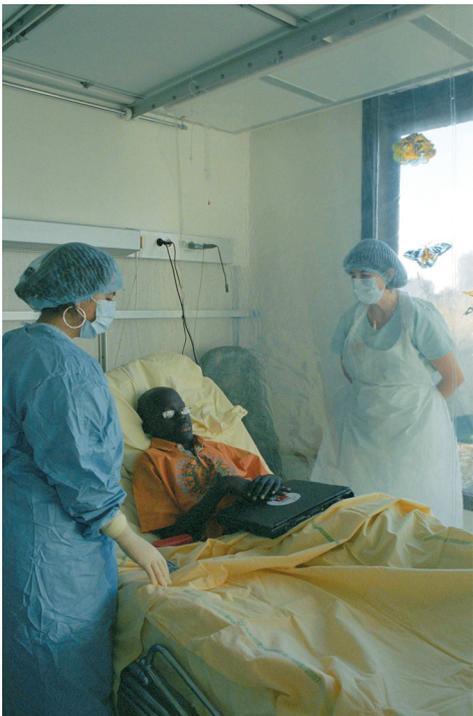
Chambre à flux laminaire : le plafond d'où l'air est injecté
